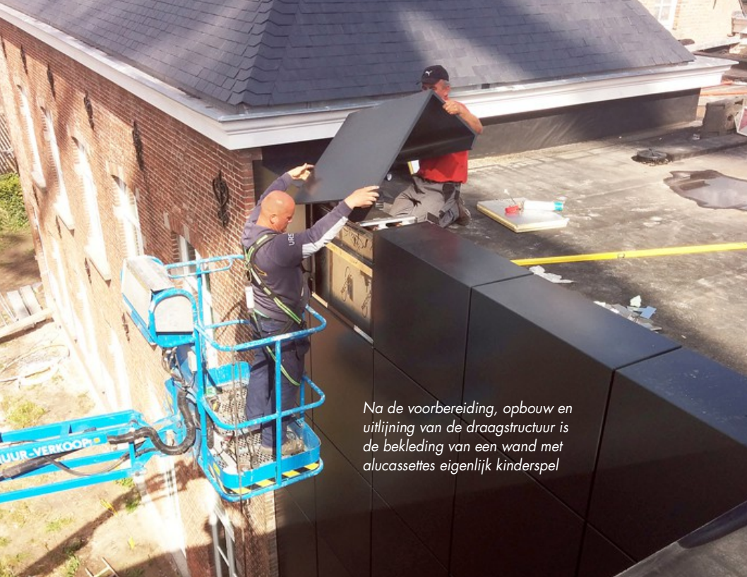
In de voegen tussen de cassettes zit een kanaal dat voor de afwatering zorgt. Een unieke eigenschap van alucassettes is hierdoor de mogelijkheid om allerlei hoekafwerkingen (buitenhoeken, ramen, nissen, deuren) integraal in de vorm van één cassette uit te voeren, zonder dat daar een extern dagkantsysteem voor nodig is
