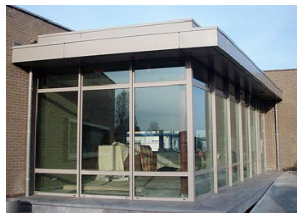
In de voegen tussen de cassettes zit een kanaal dat voor de afwatering zorgt. Een unieke eigenschap van alucassettes is hierdoor de mogelijkheid om allerlei hoekafwerkingen (buitenhoeken, ramen, nissen, deuren) integraal in de vorm van één cassette uit te voeren, zonder dat daar een extern dagkantsysteem voor nodig is
