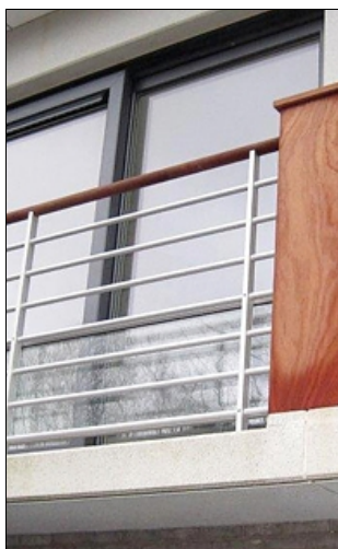
Figuur 2: Bij esthetische vlakvullende verdelingen (driehoeken, ornamenten,...) dient ervoor gezorgd dat er geen voorwerp met vermelde afmetingen door de balustrades kan gevoerd worden
