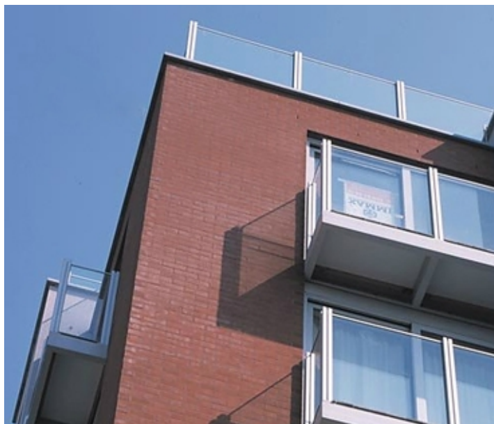
In ons land wordt het overgrote deel van balustrades uitgevoerd als aluminium constructie in combinatie met veiligheidsbeglazing
