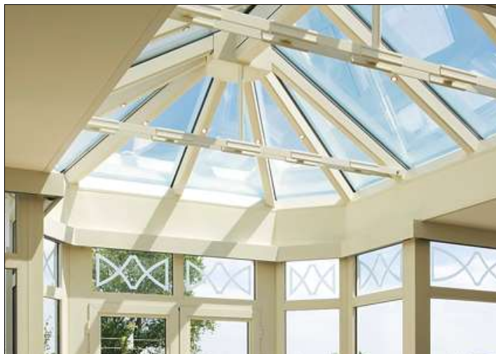
Les vérandas exécutées comme espace habitable à part entière comportent bien des sections de construction spécifiques. Leur calcul thermique est très complexe
