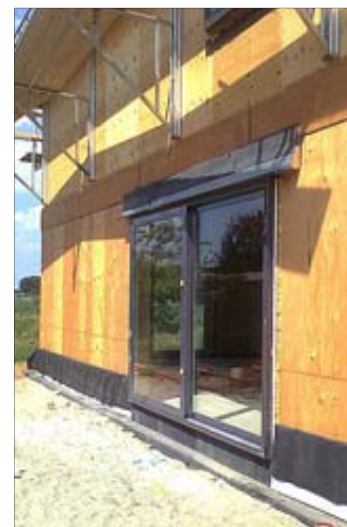
Bij deze houtskelbouw werd het aluminium raam reeds ingebouwd voor het plaatsen van de paramentsteen
