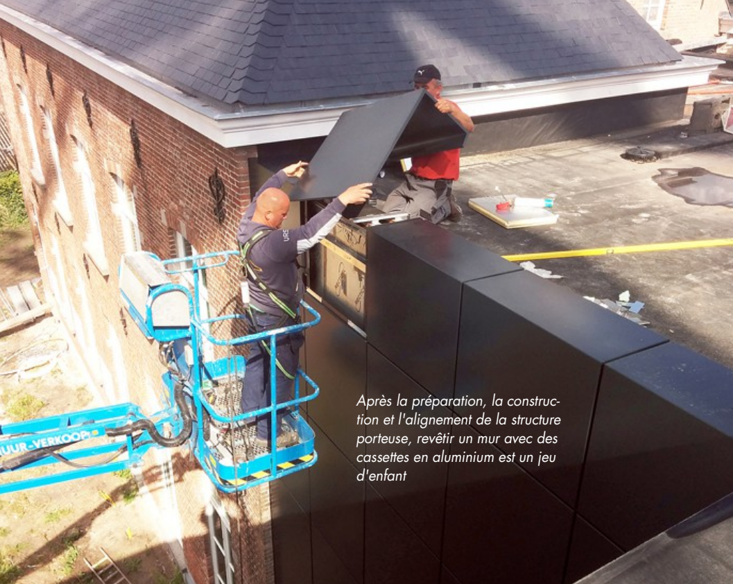
Dans les joints entre les cassettes, il y a un canal qui assure constamment l'évacuation d'eau. La caractéristique unique des cassettes en aluminium est donc la possibilité de réaliser diverses finitions de coins (coins extérieurs, fenêtres, niches, portes) en forme de cassette, sans qu'il faille un système de joue de fenêtre externe
