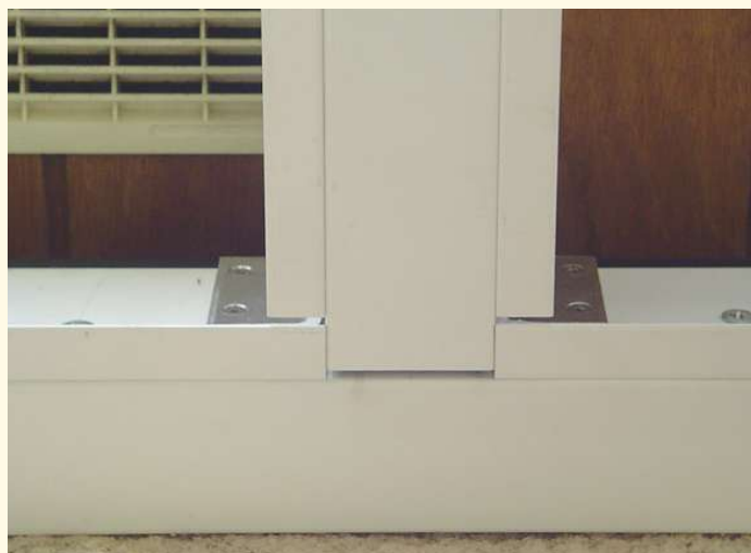
Naast de correcte berekening is uiteraard ook de uitvoering van een veranda uitermate belangrijk. De foto toont een fout door vervorming van de elementen bij het plaatsen
