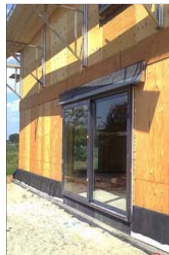
Dans le cas de cette construction à ossature en bois, la fenêtre en aluminium a déjà été intégrée avant la pose des briques de parement
